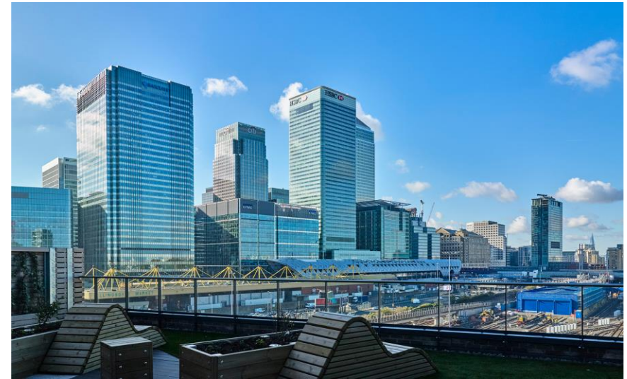
Vista della penisola di Canary Wharf
