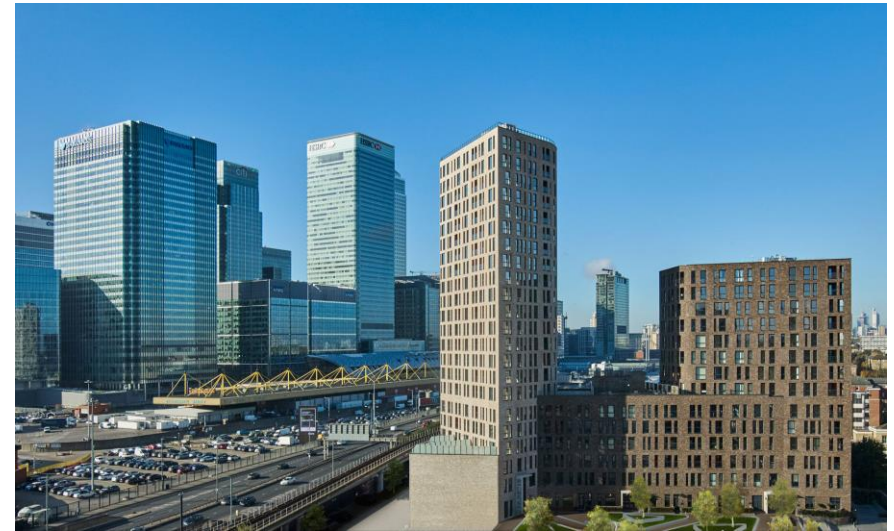
Vista panoramica del complesso
